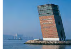
Harbour Control Tower, Lisbon, P Gonçalo Byrne, G.B. Arquitectos, Lisbon Zn-Revestimentos de Zinco Lda., Maia TECU® Classic
