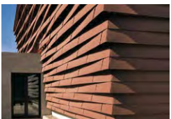
Fitness Center, Sesto Fiorentino, I Studio architetto Fabio Capanni, Florence Idroflorence S.r.l., Badia a Settimo Scandicci (FL) TECU® Classic
