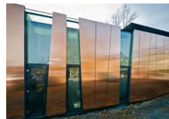
Radio-Log, Hof, D hiendl_schneis architektenpartnerschaft, Passau Franz Kraus GmbH & Co KG, Hammelburg TECU® Classic_bond
