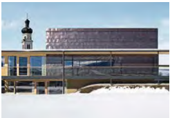
Alpine Recovery Centre, Südtirol, I AllesWirdGut Architektur ZT, Wien Spenglerei Messner Robert, Rasun Anterselva TECU® Classic
