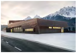
Alpine Recovery Centre, South Tyrol, I AllesWirdGut Architektur ZT, Wien Spenglerei Messner Robert, Rasun Anterselva TECU® Oxid
