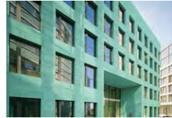
Office and shop building "KAI 13", Düsseldorf, D Döring Dahmen Joeressen Architekten, Düsseldorf Zitzen GmbH, Mönchengladbach TECU® Patina
